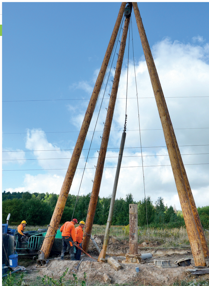
Próbny odwiert wody w Nowej Słupia
