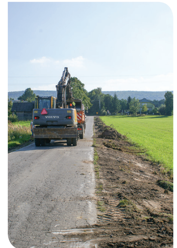
▲ Trwa remont drogi Dębno - Wojciechów
