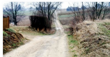
▲ Planowana do remontu droga Włochy-Hektary
