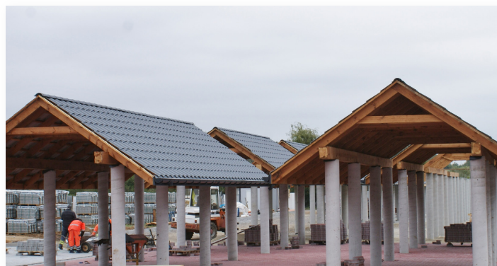
➤ Budowa Targowiska w Rudkach wkrótce zostanie zakończona
