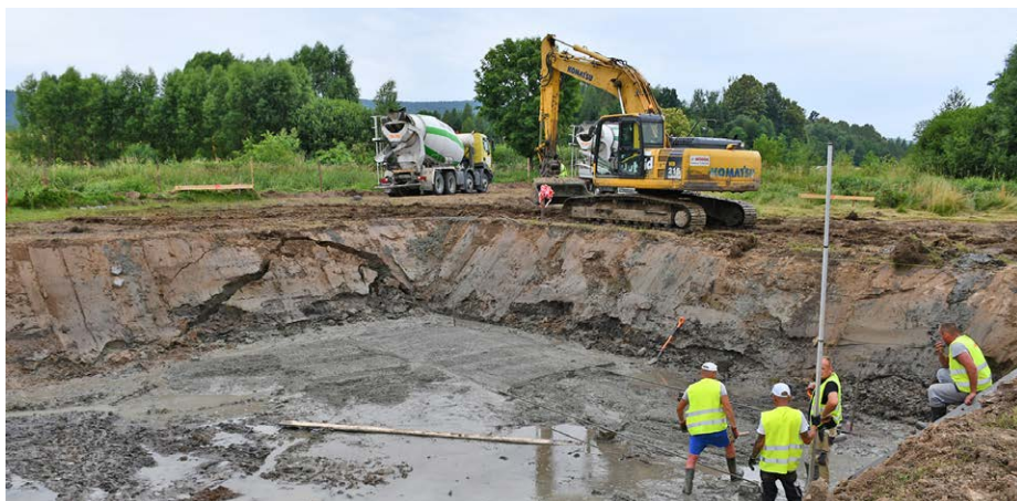
▲ Ruszyły pierwsze prace budowlane przy budowie oczyszczalni ścieków w Mirocicach.
