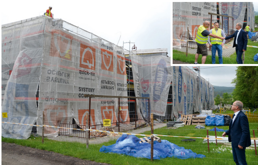
▲ Andrzej Gąsior, burmistrz Nowej Słupi cyklicznie pojawia się na terenie szkoły w Paprociach, by sprawdzić jak prowadzone są prace termomodernizacyjne.
