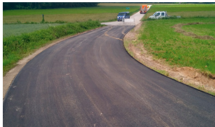
▲ Nowy asfalt jest już na drodze gminnej w Skąłach.
