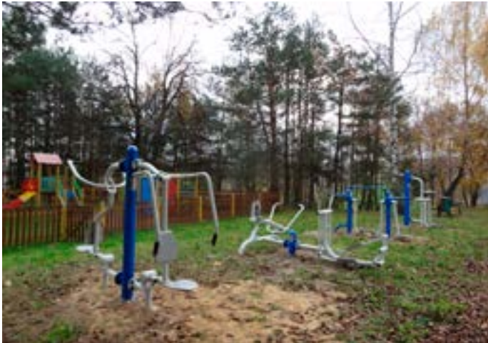
▲ Budowa siłowni zewnętrznej przy Szkole Podstawowej w Pokrzywiance – wartość 20 516,40 zł brutto.
