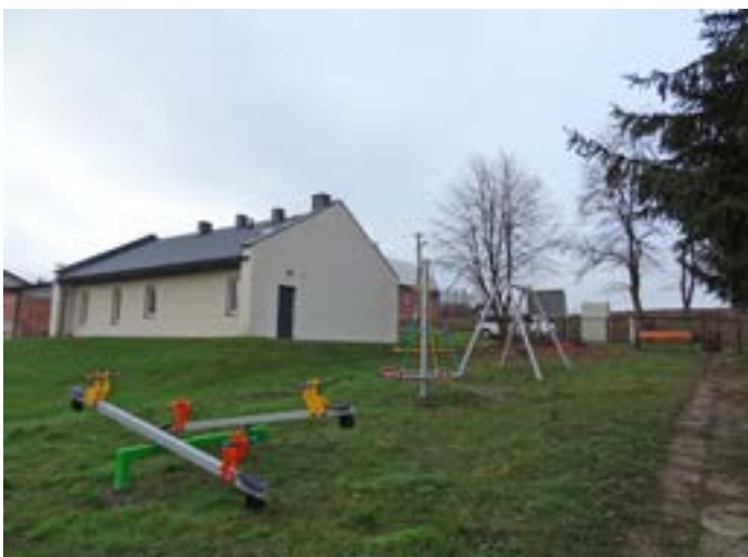
▲ Budowa placu zabaw wokół świetlicy wiejskiej w miejscowości Włochy – 15 252,00 zł brutto.
