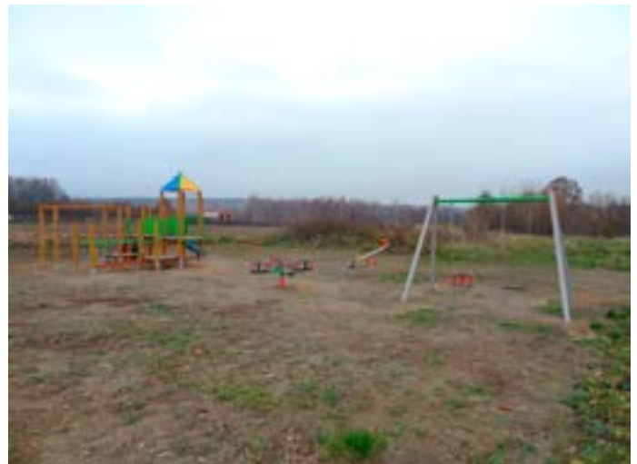
▲ Budowa placu zabaw w miejscowości Dębno obok siłowni zewnętrznej – 25 768,50 zł brutto.
